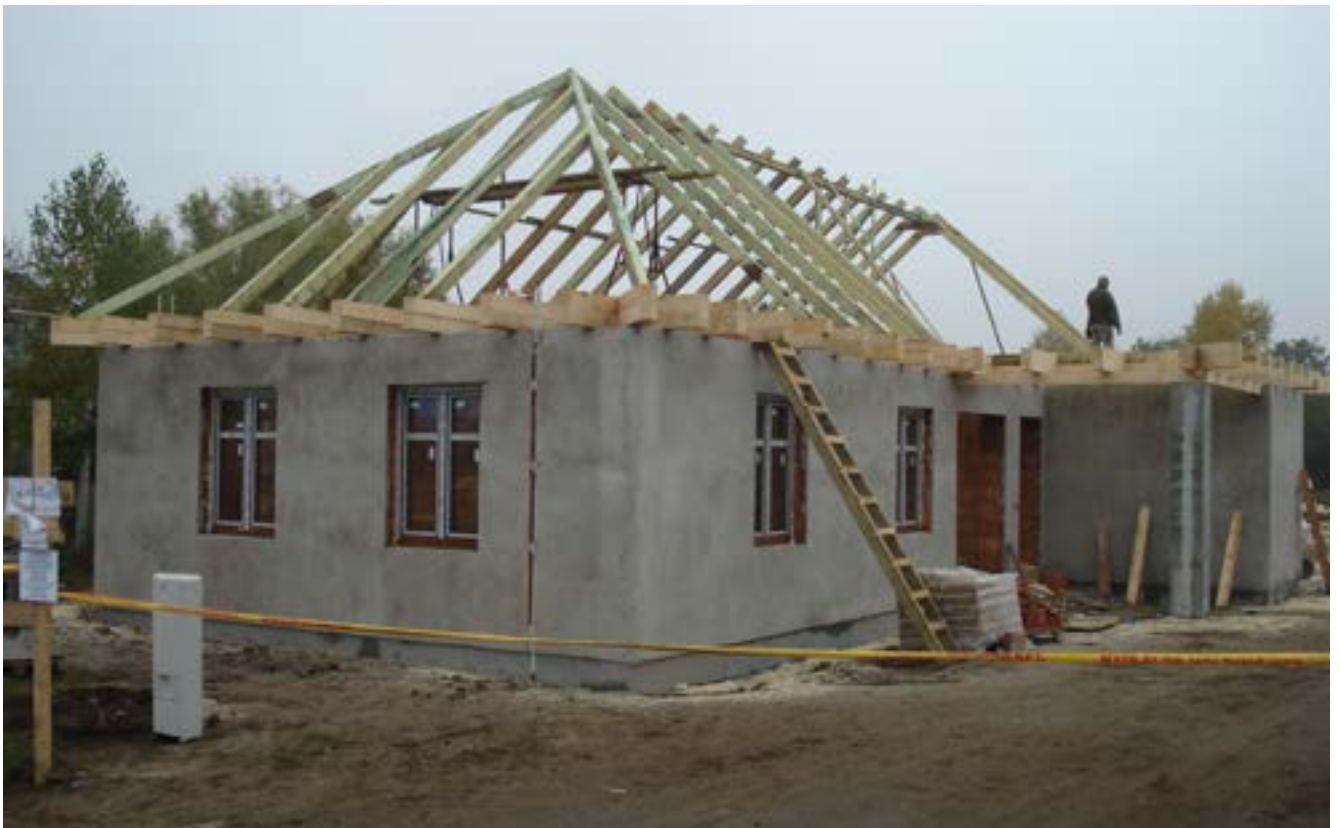
6. sz. kép: Épül az új lakóotthon Készítette: Renáta
